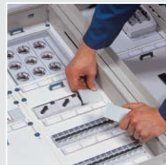
1.1 Zkouška činnosti mechanických elementů např. ovládačů, pohonu vypínače, dveří, okének.
