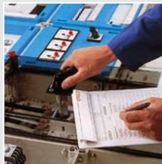
1.1 Zkouška činnosti mechanických elementů např. ovládačů, pohonu vypínače, dveří, okének.
