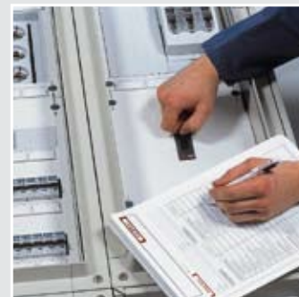
1.1 Zkouška činnosti mechanických elementů např. ovládačů, pohonu vypínače, dveří, okének.
