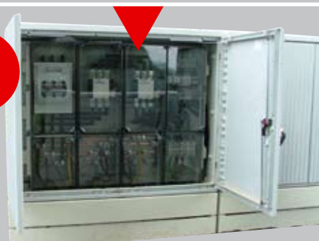
Rozdělovač, elektroměr, jističní
